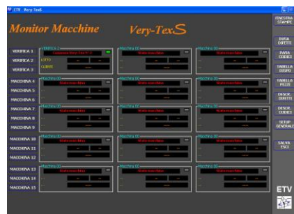
Server Very-TexS per monitoring specole e interfaccia con gestionale
